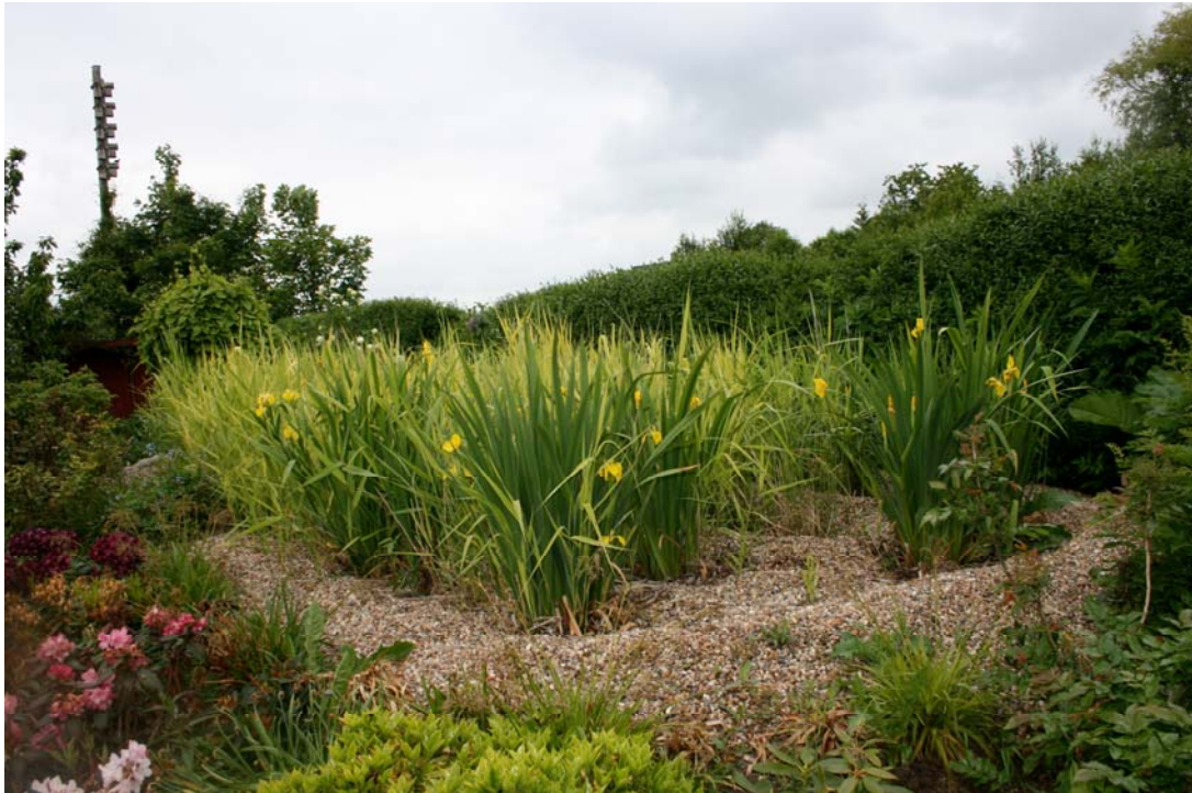
Billede: det beplantede filter integreret i en have ved Odder på 16 m 2 (5 PE)
